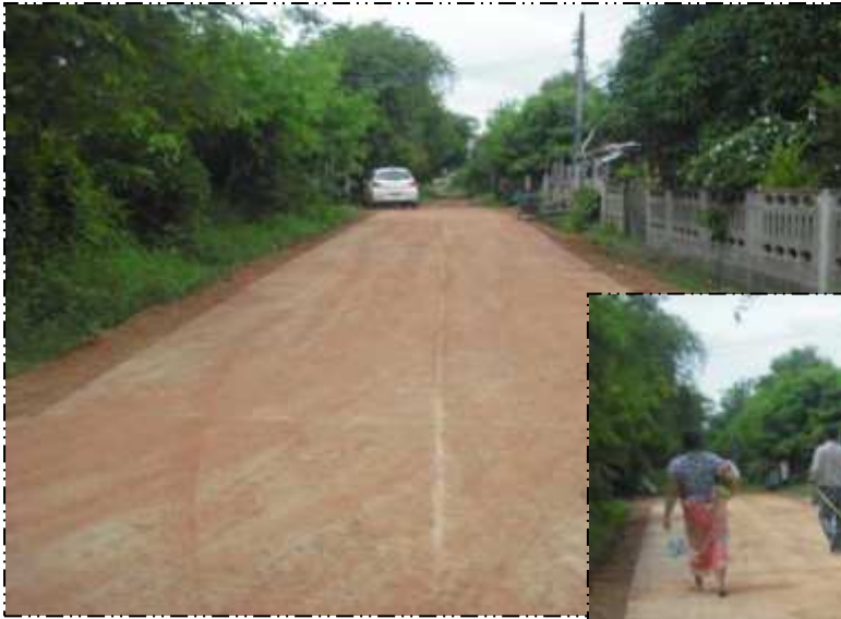
ภาพถ่ายโครงการก่อสร้างถนนคอนกรีตเสริมเหล็ก บ้านสว่างอารมณ์ ม.๑๑ (สายไปบ้านส่องฮี)
