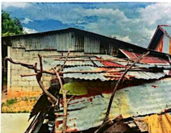
หลังคาด้านข้างที่พักอาศัยที่ทำเป็นครัว
