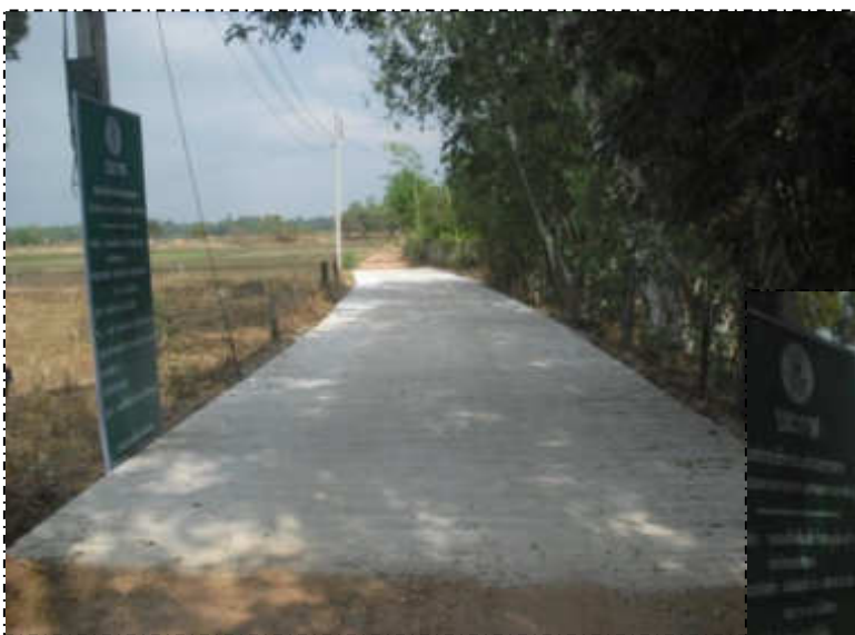
ภาพถ่ายโครงการก่อสร้างถนนคอนกรีตเสริมเหล็ก บ้านดอนยุงน้อย ม.๑๒ (สายไปคลองชลประทาน) ต.ยางตลาด อ.ยางตลาด จ.กาฬสินธุ์
