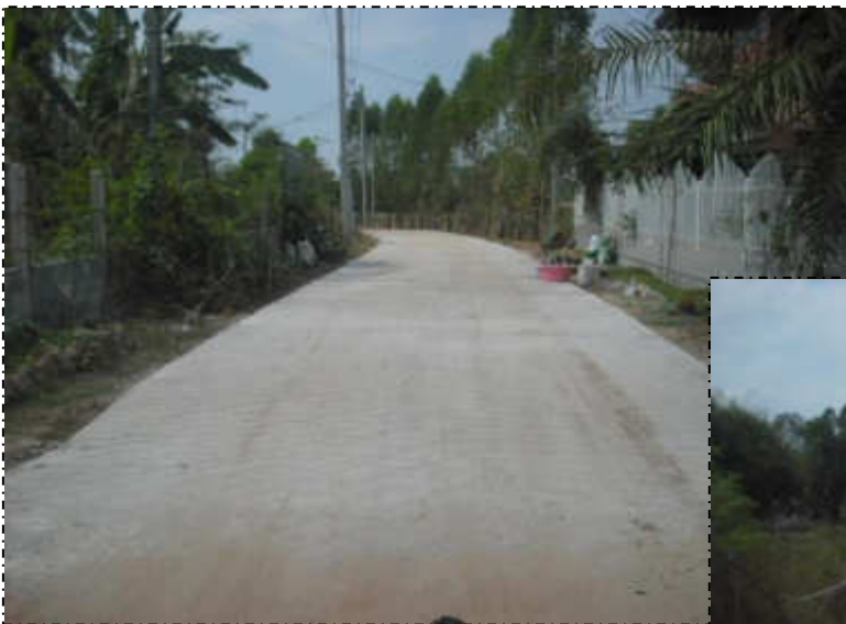
ภาพถ่ายโครงการก่อสร้างถนนคอนกรีตเสริมเหล็ก บ้านสว่างอารมณ์ ม.๑๑ (สายกลางบ้าน - ดอนปู่ตา) ต.ยางตลาด อ.ยางตลาด จ.กาฬสินธุ์
